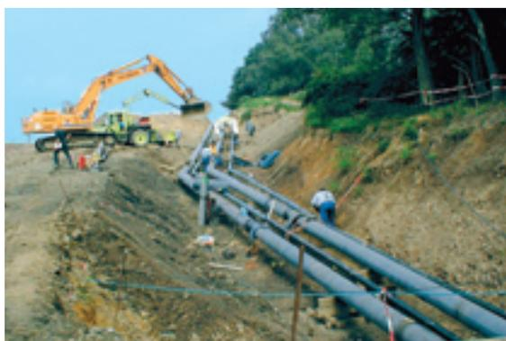
*TUBO FW DI SICUREZZA DN 100/125 e DN 300/350, 3600 m per il trasporto di nafta e cherosene*
