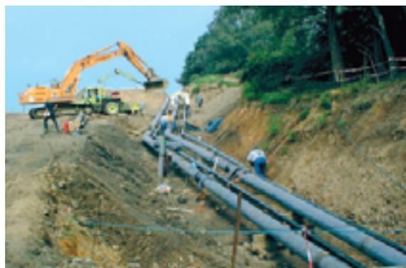
*FW-SICHERHEITSROHR DN 100/125 und DN 300/350, 3600 m transportieren Kerosin und Diesel*
