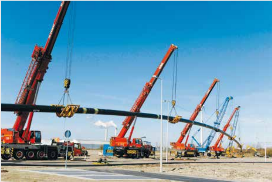
FW-STAHLMANTELROHR 500/70/700 für ein Bauvorhaben in den Niederlanden. 2 x 700 m kurz vor dem Verlegen in eine horizontalgespülte Bohrung (horizontal directional drilling).
