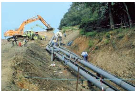
FW-БЕЗОПАСНАs ТРУБА Ду 100/125 и Ду 300/350, 3600 м, транспортирует керосин и дизельное топливо.
