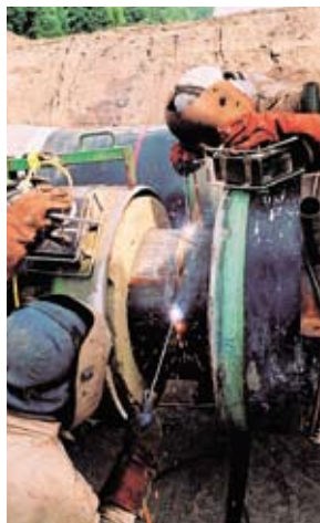
Сварное соединение конструктивных узлов
