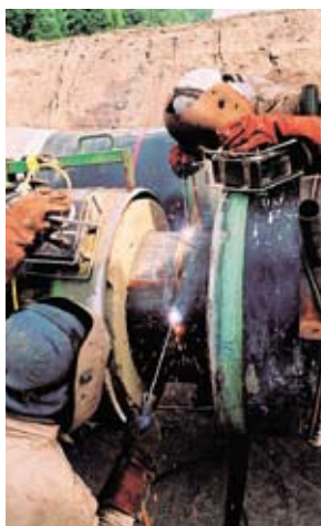
Сварное соединение конструктивных узлов
