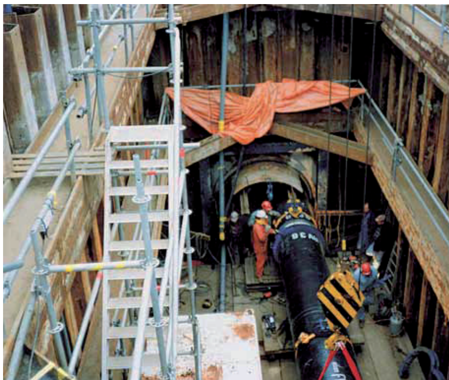
Bild 2. Bau der Dükерleitung durch den Fluß Gaasp. Die Verlegung von Vor- und Rücklauf erfolgte in einem gepressten Stahlrohr mit dem Durchmesser 2,60 m
