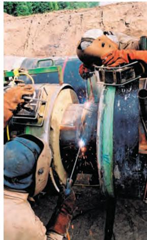
Yapı parçalarının kaynak ile birləşirilmesi
