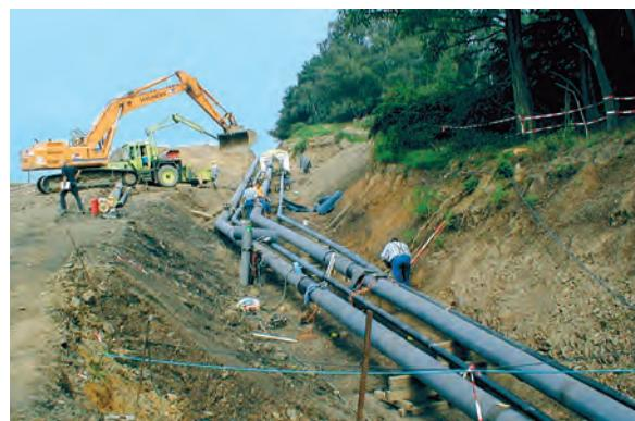
FW-EMNİYET BORUSU DN 100/125 ve DN 300/350, 3600 m kerozin ve dizel taşırl
