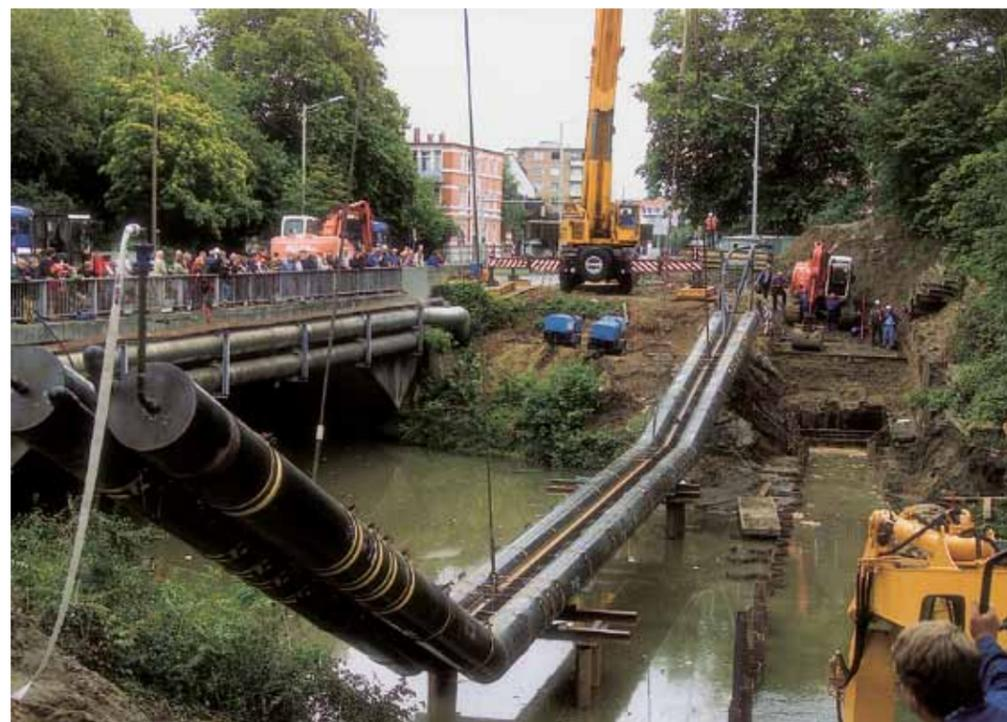
Mit Schwerlastkränen auf beiden Seiten der Oker wurde der gesamte tonnenschwere Düker angehoben...
