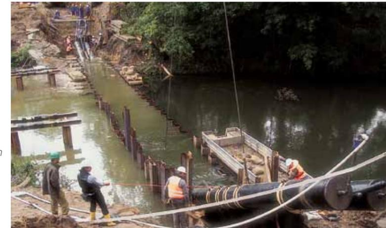
Mit hohem Vorfertigungsgrad des Stahlmantelrohrsystems und entsprechender "Dükerbau-Erfahrung" der FW-FERNWÄRME-TECHNIK GmbH sowie der sehr guten Zusammenarbeit aller am
