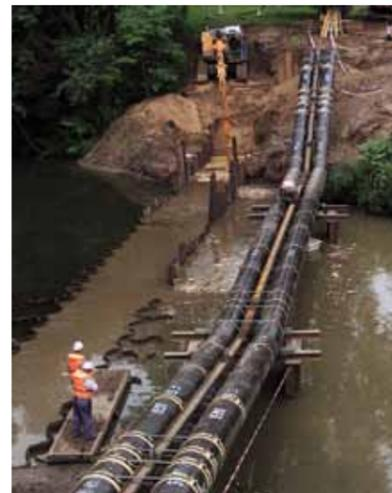
Der Mittelteil des Doppeldükers wurde in einer Länge von 31 m auf Stützen über dem Fluss ausgelegt.
