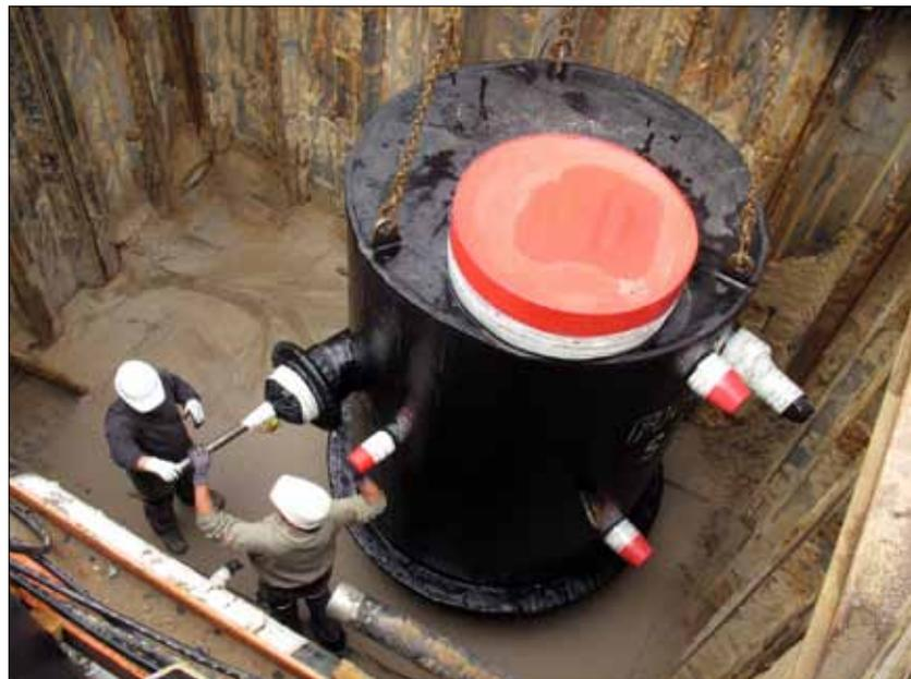
Bild 5. Einbringung eines Kondensatschachts
