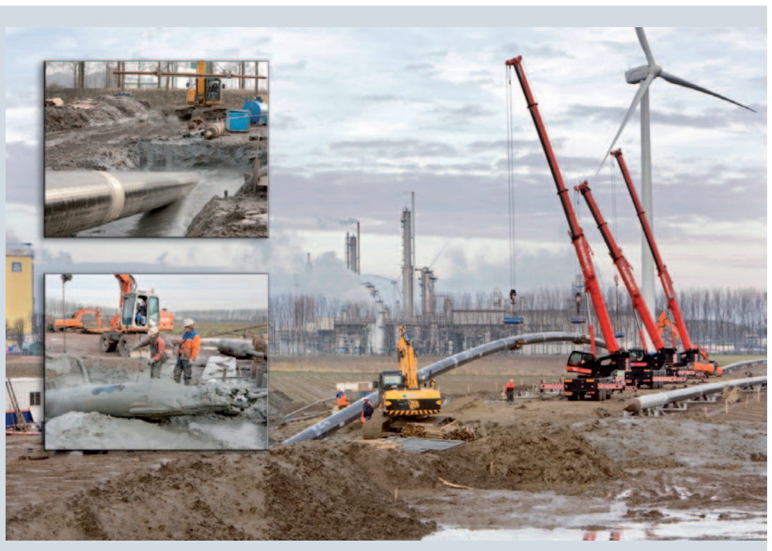
BILD 1: Stahlmantelrohrleitung verlegt im Horizontalspülbohrverfahren: Düker Terneuzen, NL
