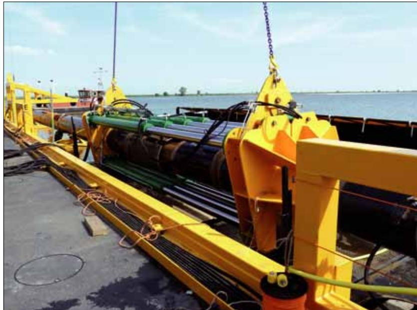
Bild 4. Montageponton mit hydraulischer Vorspanneinrichtung
