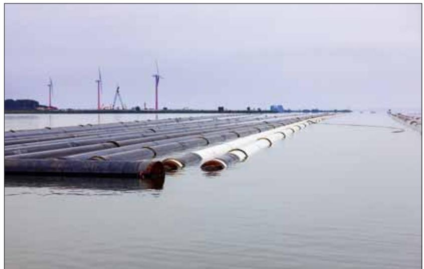
*Bild 3. »Parkplatz« der zu Teillängen von 500 bis 700 m verschweißten und an den Enden verschlossenen Rohre*
