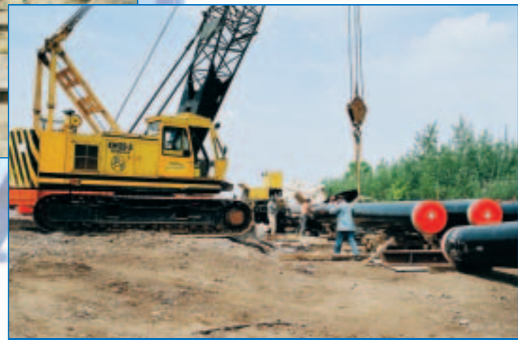
Verschweißte Stränge der Stahlmantelrohre auf der Montagebahn in Verlängerung der Dükerachse
