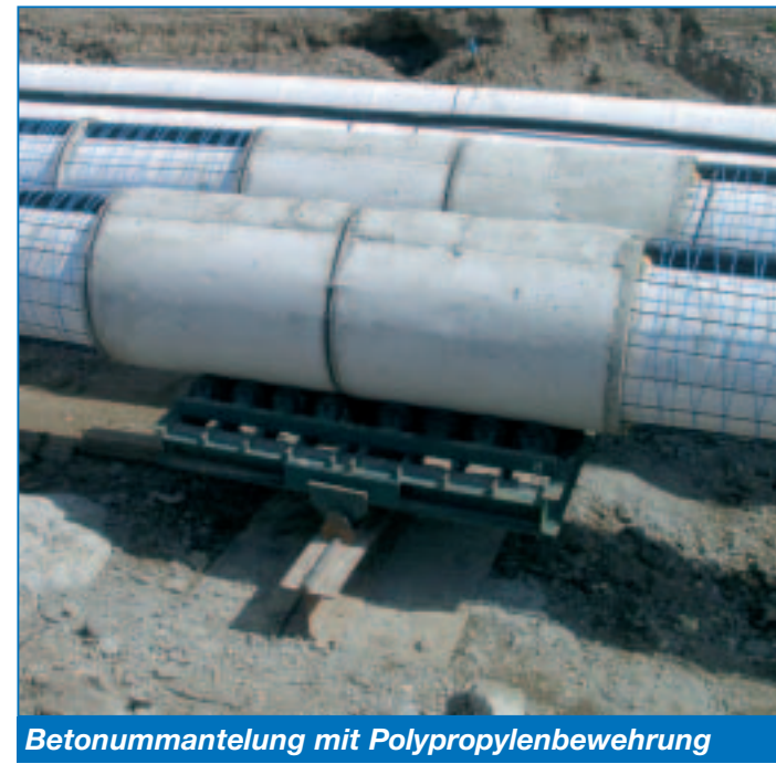
Betonummantelung mit Polypropylenbewehrung
