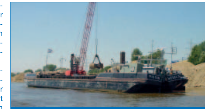
Verklappung der Baggermassen mit Hydroklappschuten
