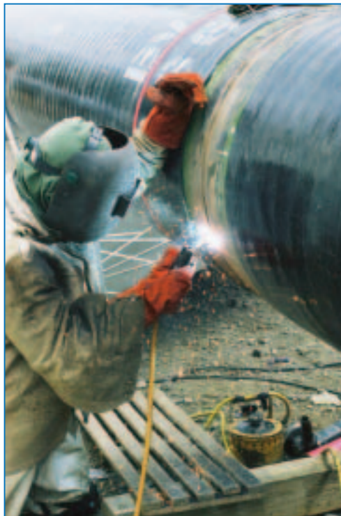
Herstellen einer Rundschweißnaht am Mantelrohr
