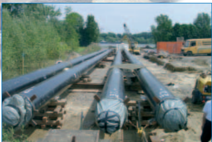
Rohrvorbau – Auflegen und Montieren der Stahlmantelrohre
