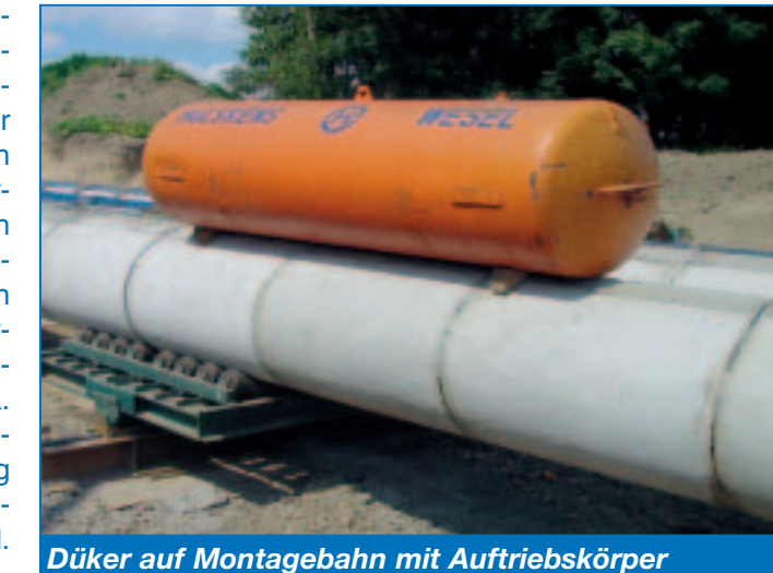
Düker auf Montagebahn mit Auftriebskörper
